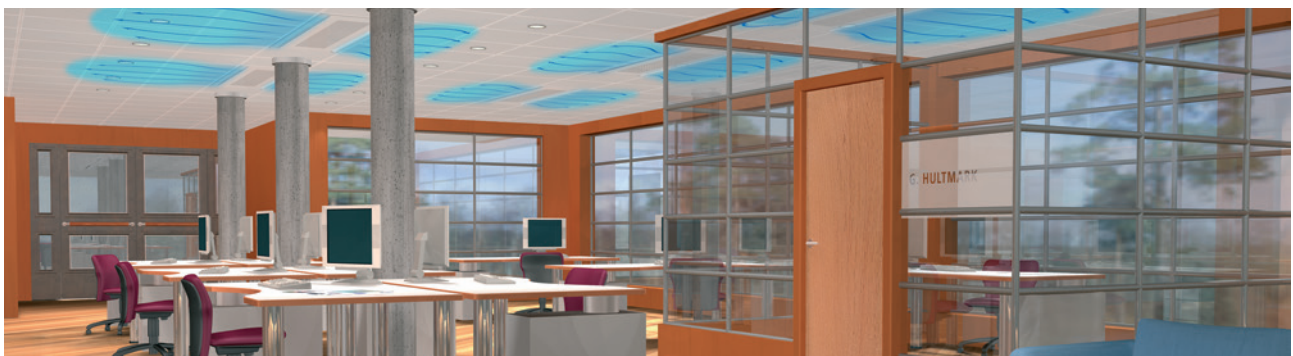
Bild 6. Ett separat kontorsrum skall byggas in i lokalen. För att klimatet skall bli optimalt måste luftmängd och luftspridning justeras på den Premax-baffel som byggs in i det nya rummet.
